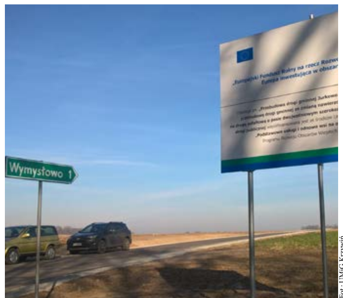
Przebudowana droga Jurkowo — Wymysłowo w gminie Krzywiń. Zadanie zostało dofinansowane na kwotę blisko 1,8 miliona złotych ze środków PROW 2014–2020.
