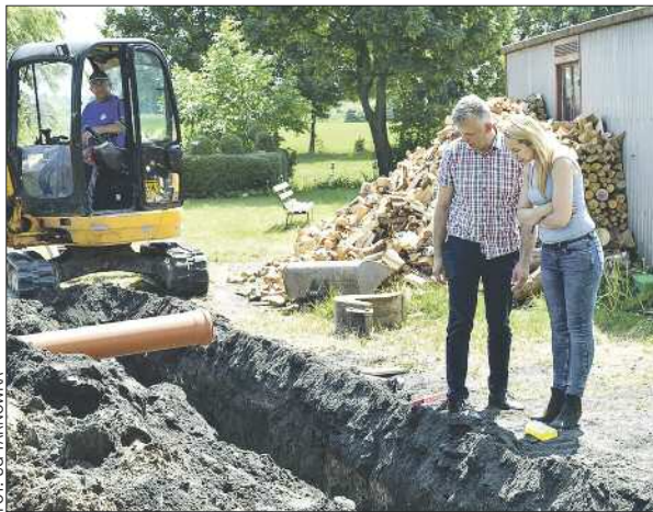
Wójt gminy Tarnówka Jacek Mościcki dołącza budowę przydomowych oczyszczalni ścieków w Tarnowcu.
