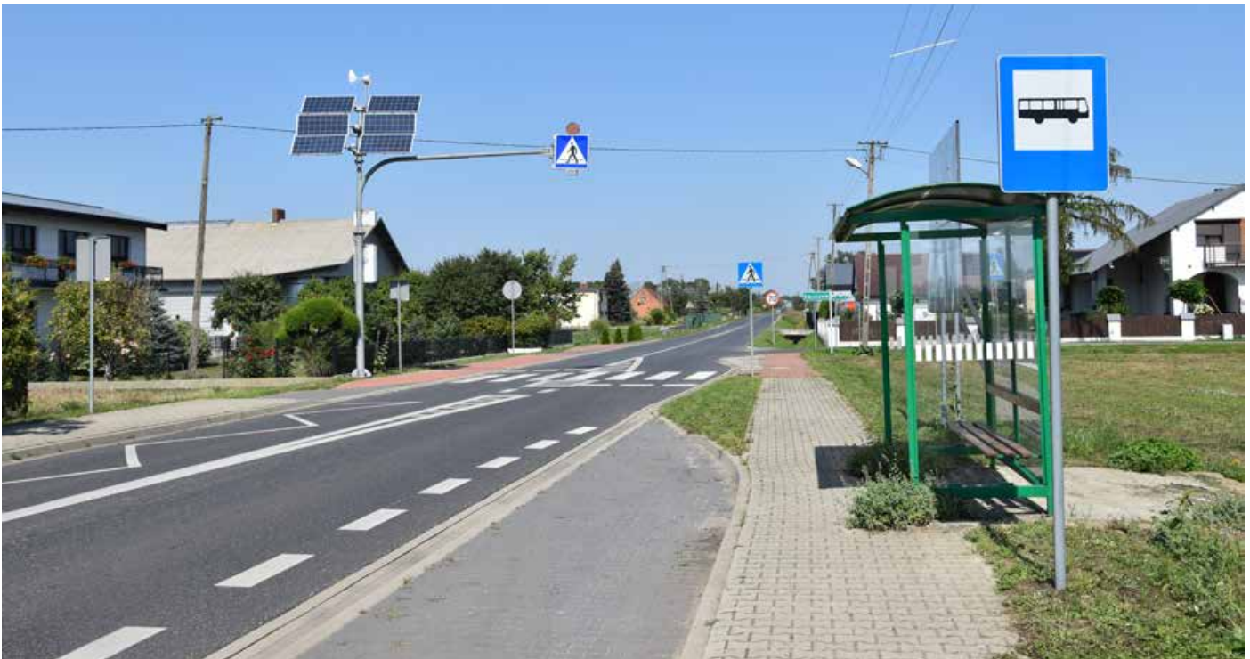
Przebudowana droga powiatowa Ludomy – Ryczywół na odcinku Ludomy – Gorzewo. Władze powiatu obornickiego pozyskały na inwestycję środki z PROW 2014-2020.
