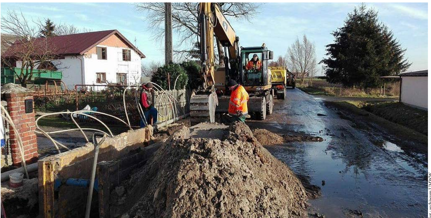
Dzięki środkom z PROW możliwa była budowa kanalizacji sanitarnej z przykanalikami w miejscowości Grodziec na ulicach Wiejskiej i Mickiewicza, wraz z działkami (etap II). Wartość dofinansowania z PROW to kwota w wysokości 1 145 338 złotych.
