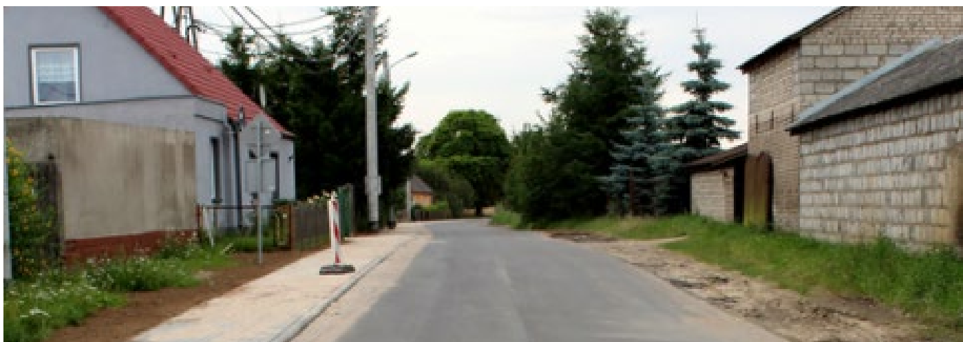
Przebudowana droga powiatowa Paruszka – Podróżna na terenie powiatu złotowskiego.
