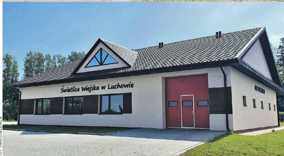
FUNDUSZE Z PROW 2014-2020 ZMIENIAJĄ WYGLĄD WIELKOPOLSKIEJ WSI. NA ZDJĘCIU ŚWIETLICA W ŁOŻBZENICACH, PRZED I PO REMONCIE.
