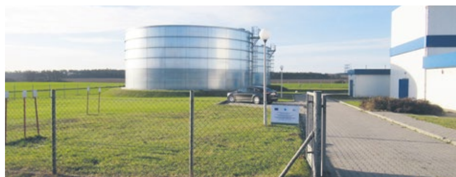
Fundusze z Programu Rozwoju Obszarów Wiejskich na lata 2014-2020 z przeznaczeniem na realizację inwestycji w zakresie gospodarki wodno-ściekowej pozyskał Zakład Usług Komunalnych w Dopiewie. Beneficjent zrealizował projekt pn. „Budowa magistrali wodociągowej Konarzewo-Dopiewiec oraz kanalizacji sanitarnej w Konarzewie w Gminie Dopiewo”.
