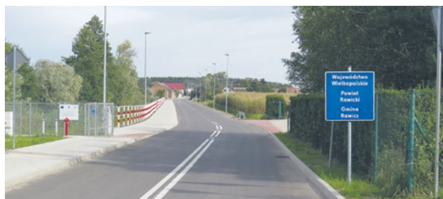
Przebudowana ulica Wrocławska w Dębnie Polskim w gminie Rawicz. Inwestycję zrealizowano przy wsparciu z PROW 2014-2020.
