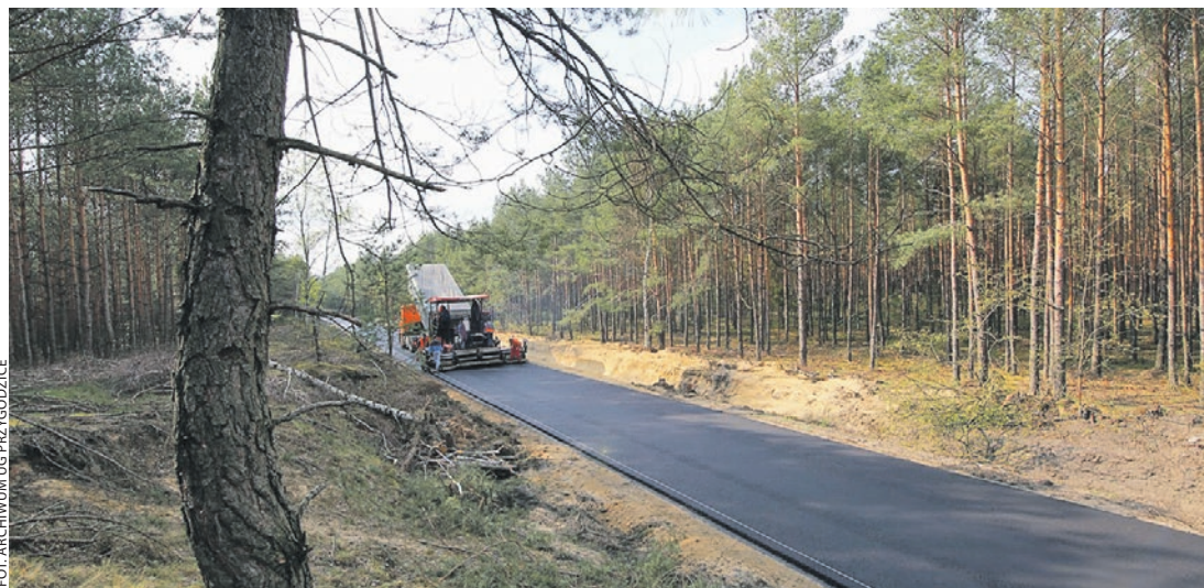
Przebudowa drogi na odcinku Antonin – Przygodziczki (Kłady) w gminie Przygodzice. Inwestycję dofinansowano z PROW 2014-2020. Dokument zaprezentowany przez ministerstwo nie przewiduje wsparcia dla lokalnych samorządów na tego typu przedsięwzięcia.
