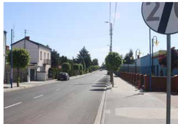
Przebudowa ul. Warszawskiej w Sompolnie i drogi gminnej w Sompolniku dofinansowana z PROW.
