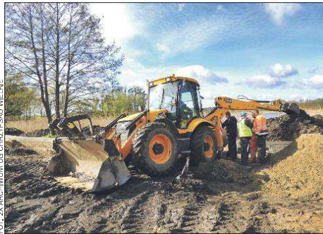
Początkowe prace budowlane na ul. Jeziornej w Chrzypsku Wielkim...
