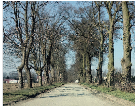
Na terenach wiejskich brakuje często dobrej infrastruktury drogowej. Wsparcie z Programu Rozwoju Obszarów Wiejskich na lata 2014-2020 przyczyni się do poprawy stanu dróg w mniejszych miejscowościach.
