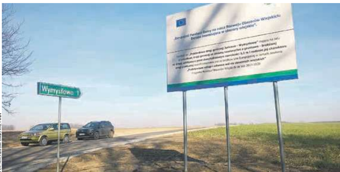
Przebudowana droga Jurkovo-Wymysłowo w gminie Krzywiń. Zadanie zostało dofinansowane na kwotę blisko 1,8 miliona złotych ze środków PROW 2014-2020.
