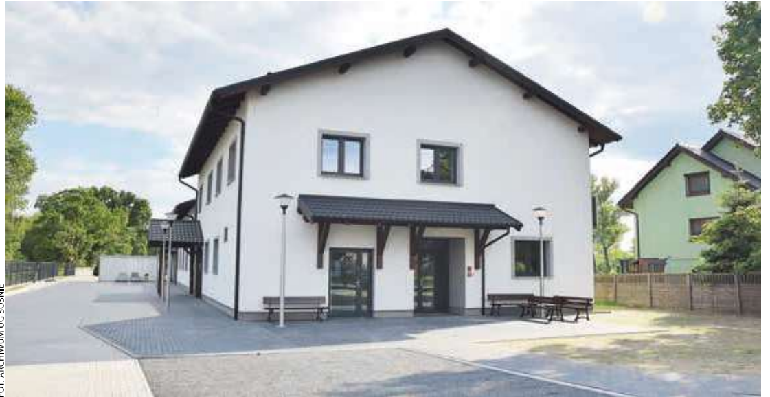
Na zdjęciu rozbudowana świetlica wiejska w Granowcu w gminie Sośnie w powiecie ostrowskim. Projekt dofinansowano z PROW 2014-2020 na kwotę 500 tys. zł.
