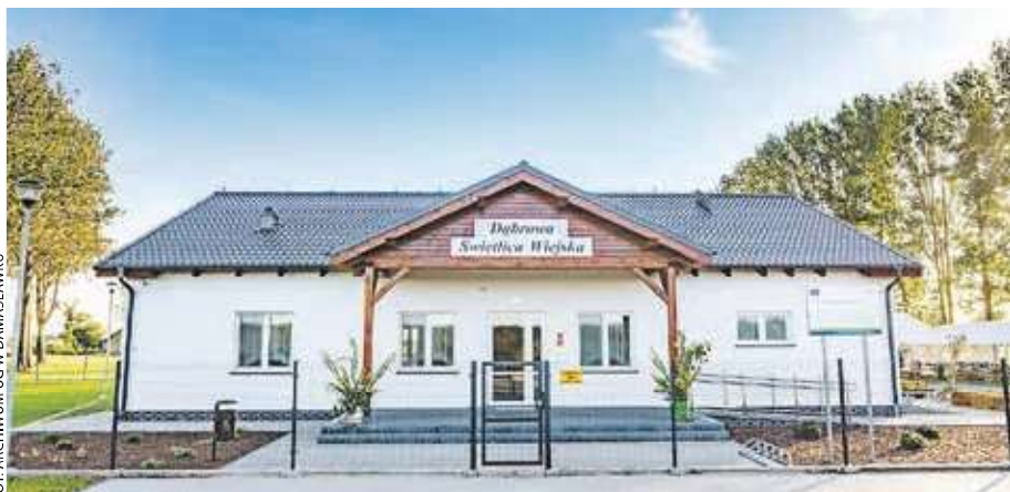
Gmina Damasławek dzięki dofinansowaniu z PROW wybudowała świetlicę wiejską w Dąbrowie.
